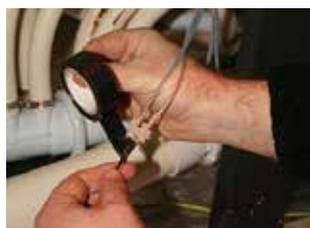
**ÉTAPE 7** - Isoler les fils avec du ruban électrique avant le remontage
