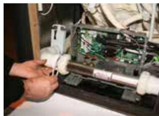
**ÉTAPE 9** - Enlevez les vieux joints d'étanchéité du chauffe eau et remplacer avec les nouveaux.
