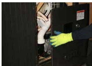
**ÉTAPE 2** - Retirez les bandes de panneau et panneaux latéraux (sur le côté du clavier de controle)
