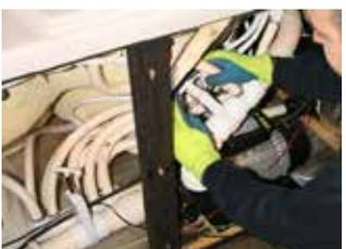
**ÉTAPE 4** - Fermez les deux robinet guillotines pour isoler l'eau
