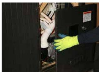
**ÉTAPE 2** - Retirez les bandes de panneau et panneaux latéraux sur le côté du clavier de controle
