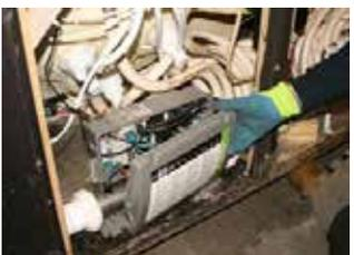
**ÉTAPE 5** - Dévissez le couvercle du boîtier de contrôle à l'aide d'un tournevis a tête Phillips
