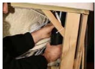
**ÉTAPE 4** - En utilisant le corps de l'haut-parleur dévisser en tournant dans le sens antihoraire (Remarque: l'écrou est collé en place dans du sellant)
