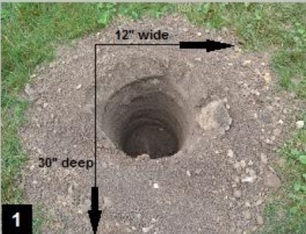
1 Dig Hole : Dig hole 12" wide x 30" deep
