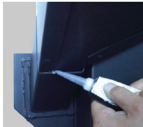
Fill the entire void
