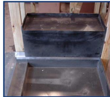
Fotografía de Instalación 6
