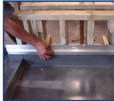
Fotografía de Instalación 4
