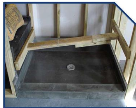
Photo d'installation No 8
