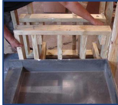
Fotografía de Instalación 2
