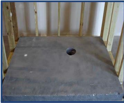
Fotografía de Instalación 1
