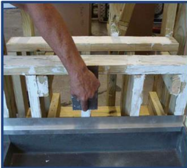
Photo d'installation No 5
