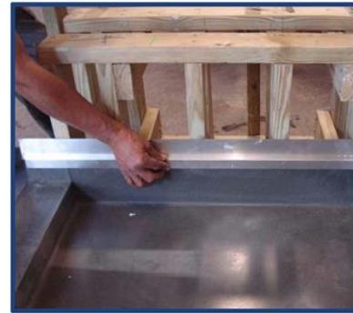
Photo d'installation No 4
