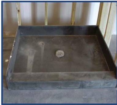
Photo d'installation No 3
