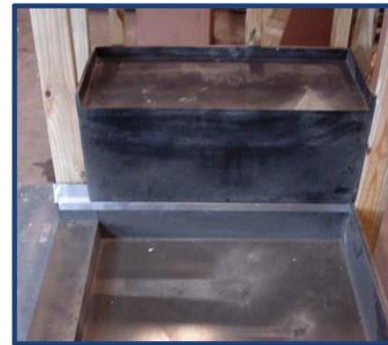
Photo d'installation No 6
