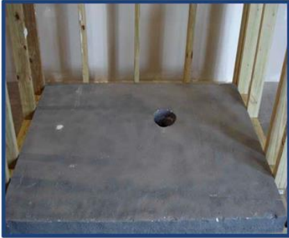
Photo d'installation No 1
