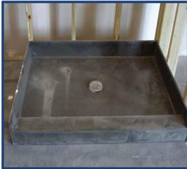
Fotografía de Instalación 3
