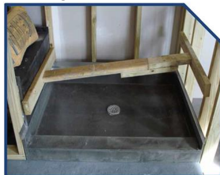
Fotografía de Instalación 8
