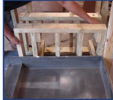
Photo d'installation No 2
