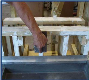
Fotografía de Instalación 5
