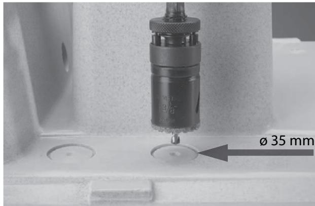
**IT - FORO PER IL RUBINETTO.** Il lavello è predisposto per l'installazione del rubinetto su entrambi i lati con un preforo non passante Ø35 mm. Ciò consente la scelta del verso del posizionamento al momento dell'installazione da parte dell'utente. Il completamento del foro, nel verso desiderato, può essere adeguatamente effettuato agendo dal lato non a vista del lavello, utilizzando una fresa a tazza Ø35mm. (reperibile presso qualsiasi ferramenta) montata su un normalissimo trapano manuale.
