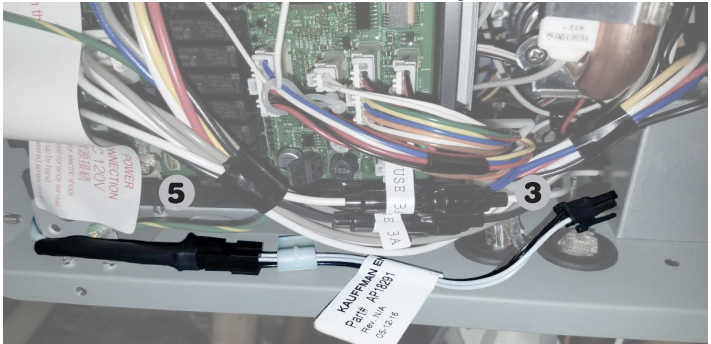
Figure 1 - Références 5 et 3 connectées - Emplacement suggéré pour le détecteur : Faites passer le cordon du détecteur d'eau depuis le côté gauche du chauffe-eau vers son arrière en passant par l'arrière de la carte de contrôle. C'est illustré en Figure 2.
