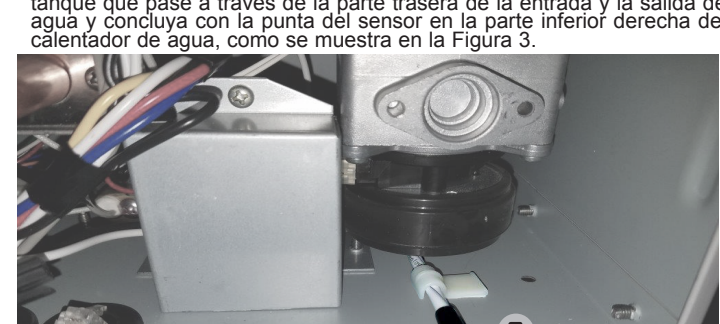
Figure 3. 3. Asegúrese de que el sensor de agua AP17980-1 (5) esté en contacto con el fondo del gabinete. Use los clips provistos para sujetar el sensor de agua.
