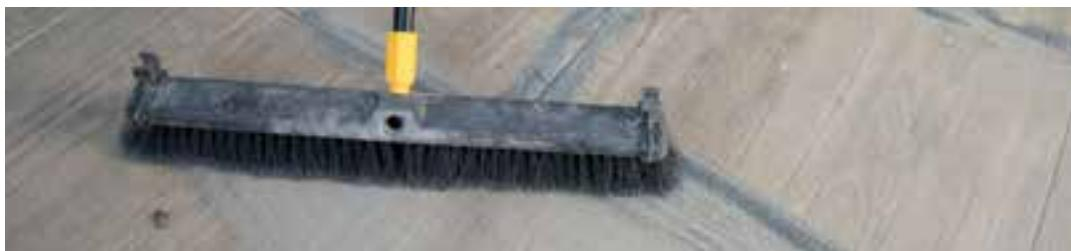
Retire los separadores y comience a barrer la arena polimérica sobre las juntas. La arena polimérica se debe instalar de acuerdo con las instrucciones proporcionadas por el fabricante. No utilice un compactador de placa vibrante en la superficie de porcelana. Un mazo de goma / PVC puede utilizarse para ayudar a que las piezas de porcelana se adhieren al sustrato.
