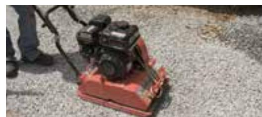
Prepare una sub-base a una profundidad de 4" usando gravilla de  $\frac{3}{4}$ " para permitir el drenaje y la estabilidad. Compacte y nivele la sub base con una pendiente del 2% alejándose de edificios y cimientos. Humedezca ligeramente la sub-base para una mejor compactación.
