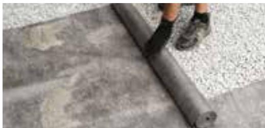
Cubra el sustrato con la tela Geotextil. Asegúrese de seguir las instrucciones específicas del fabricante de la tela. La tela aumentará la estabilidad y la longevidad de la instalación.
