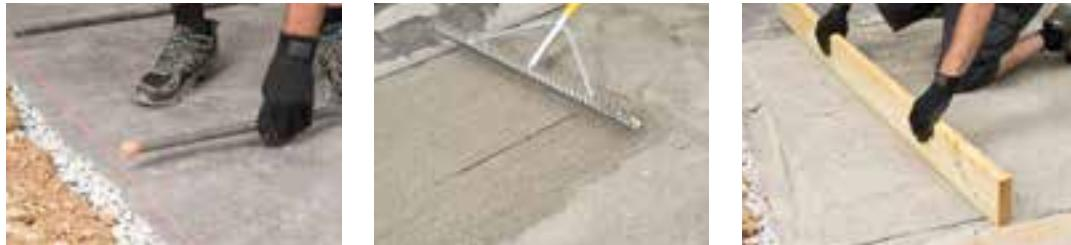
Coloque una guía de nivelación de 1" de grosor cada dos pies y rellene esta altura con material de base. Pase una tabla plana sobre las guías para nivelarlas, asegurando una pendiente de al menos el 2% alejándose de cualquier edificio o cimiento. Retire guías de y rellene los huecos con material de base.
