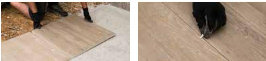
Seleccione el tamaño y tonalidad de las piezas, y coloquelas suavemente sobre la superficie preparada. Completé el esquema de colocación de acuerdo con las especificaciones del proyecto o con sus preferencias.
