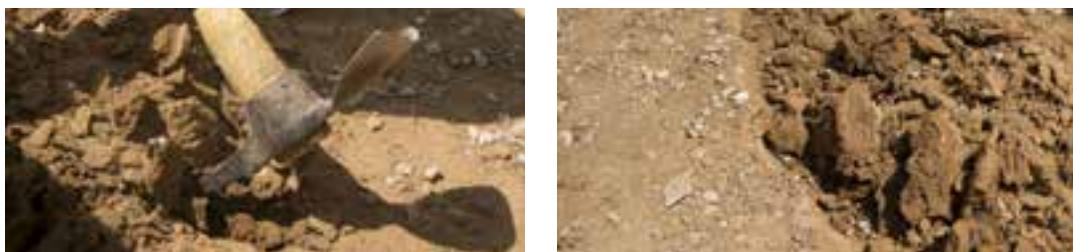
Cuando excave, asegúrese que excava una profundidad suficiente para que incluya toda la base. La profundidad de la base viene determinada por las condiciones preexistentes del suelo y el clima en su región. La mayoría de los suelos normales requerirán una profundidad total de 5".
