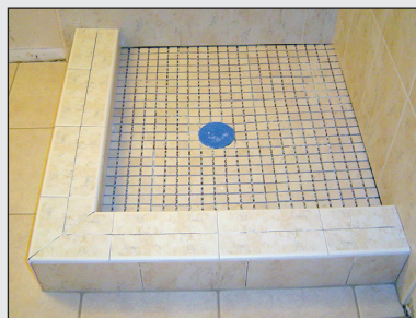
Kirb-Perfect MD recouverte de carreaux
