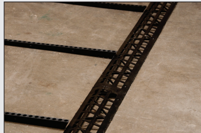
Positionnement brut de la bordure Handi-Kirb MC mince
