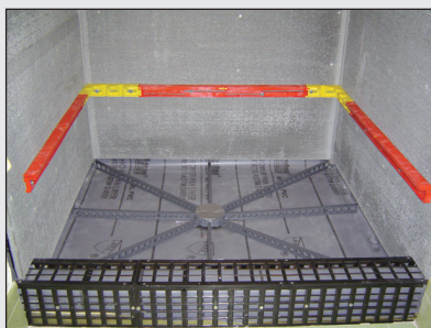
Fixer les morceaux StringA-Level MC au mur
