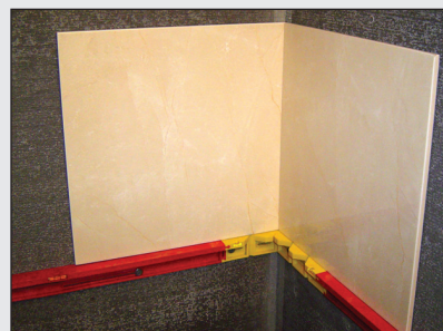
Coloque los azulejos sobre el StringA-Level™
