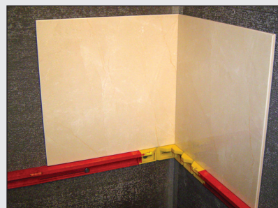
Placer le carreau sur StringA-Level MC
