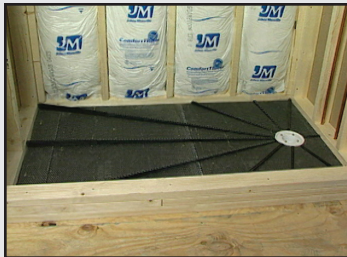
Pre-Pitch™ estándar y de extensión, colocación preliminar.
