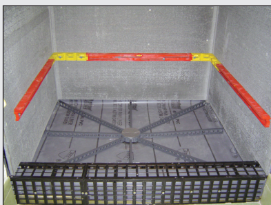
Fije las secciones de StringA-Level™ a la pared
