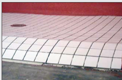
Fini de la bordure Handi-Kirb MC standard
