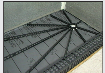
Quick-Pitch® estándar y de extensión y Kirb-Perfect®, instalados.
