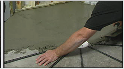
Comblé avec du mortier
