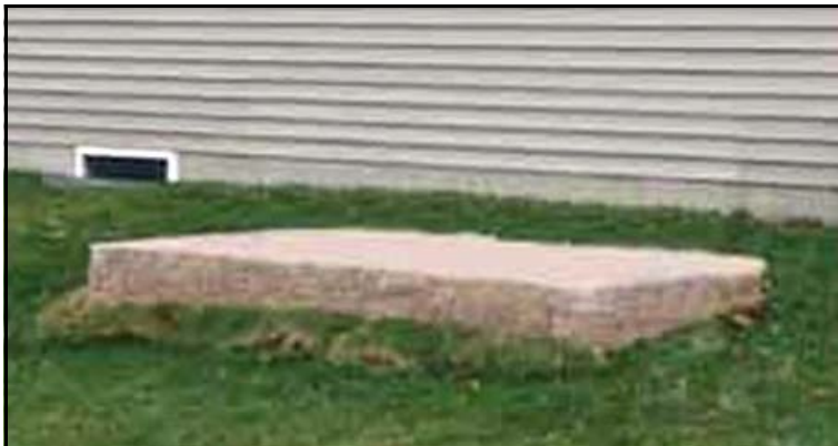
Figure 3-4. Plateforme de béton
