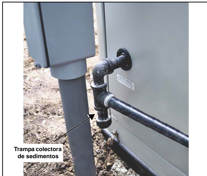
Figura 5-3. Trampa colectora de sedimentos
