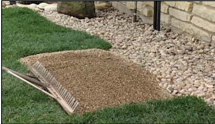
Figura 3-3. Sitio con gravilla compactada
