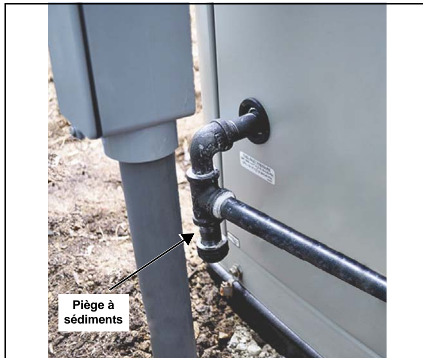
Figure 5-3. Piège à sédiments
