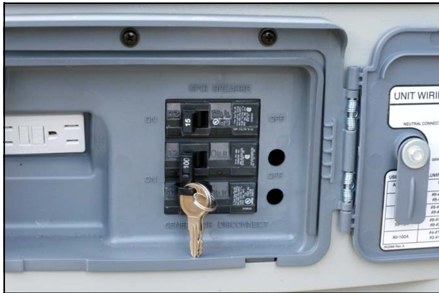
Figura 2-3. Caja del disyuntor y llaves (como se envían)
