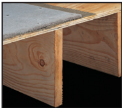
Substrato de 5/8" con vigas a una distancia de 16" del centro de cada una
