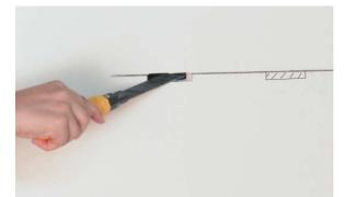
**STEP 4** – USE DRILL TO START CUTTING THE GROOVES, FOLLOWED BY USING THE WALL-SAW. ONLY CUT THE AREA THAT IS MARKED. THEN, TEST TO FIT THE SHELF INTO THE GROOVES. **CLEAN ALL GROOVES AND WALLS FREE OF DUST**.
