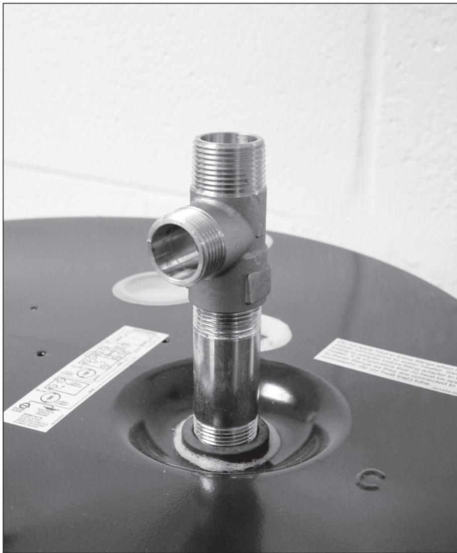
4. Aplique cinta selladora a las roscas machos de la válvula mezcladora y del T. Examine la orientación de ambos instalados para asegurar que permita la conexión de la manguera flexible.
