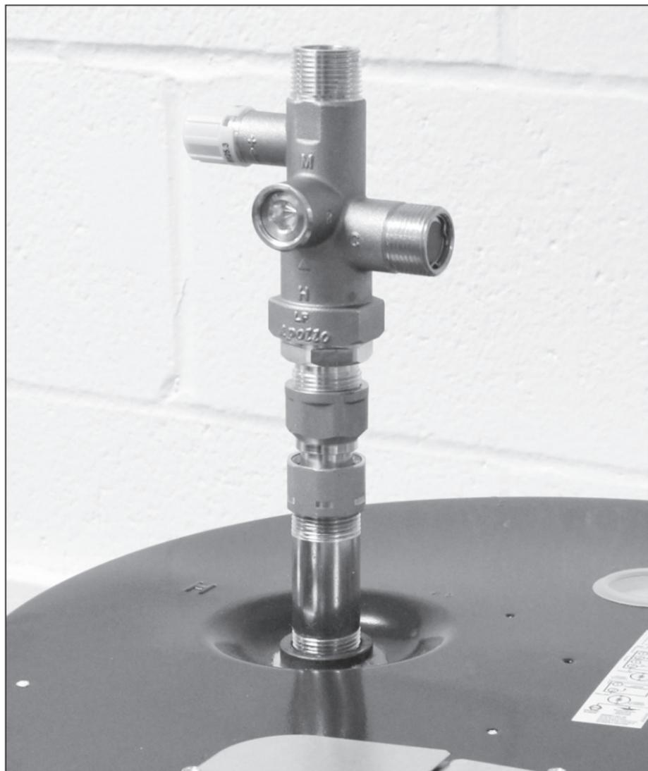
3. Conecte el acople T a la entrada de agua fría del calentador.
