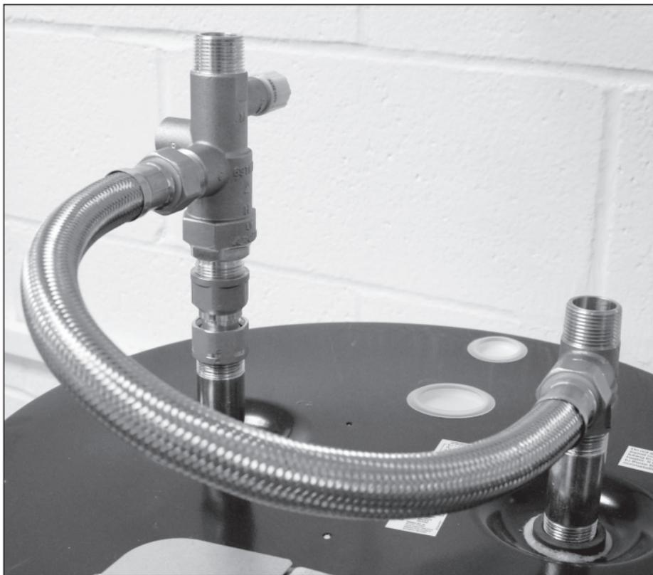
6. Conecte el tubo de suministro de la entrada del agua fría al T, y el tubo de suministro de salida del agua caliente a la válvula mezcladora.
